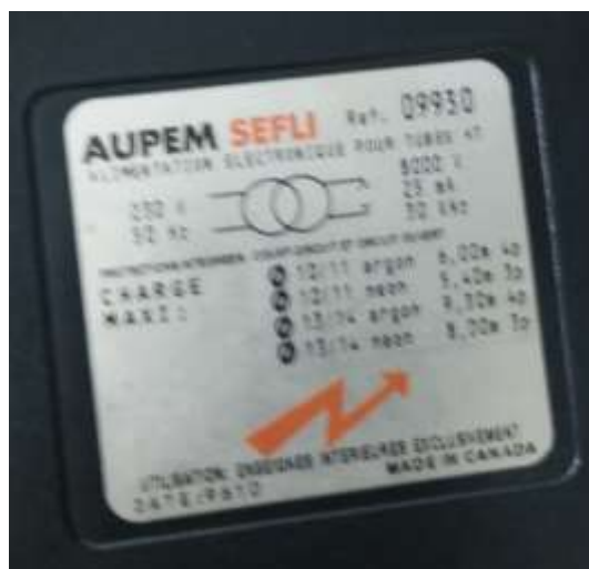
Figura 3.4. Specificația sursei de 30 kHz
