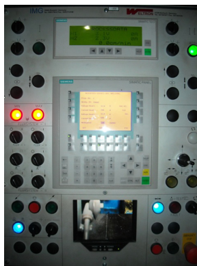
Fig. 8.2. Pupitrul de comandă al instalației de sudare
