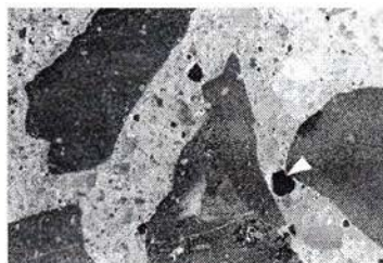
Fig. 7.7 Suprafața betonului cu macroporozități. Macroporul de 2 mm în diametru este marcat cu săgeata – nivel III
