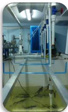
Fig. 2.10. Suport metalic pentru asigurarea susținerii și stabilității unităților acvaponice. (foto. original)
