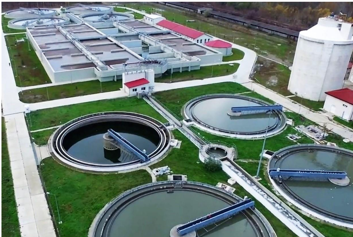
Fig. 2.1 – Imagine de ansamblu a stației de epurare Galați [75]
