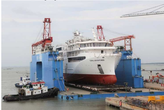
Figura. 1.7. Docul plutitor aflat in exploatarea S.N. VARD Vung Tau, Vietnam [22]
