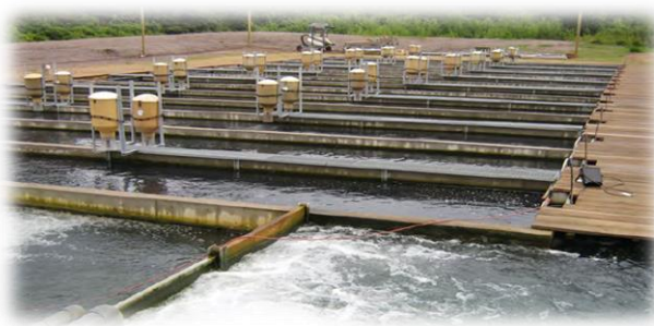
Figura 3.2-Sistem recirculant (RAS) în aer liber
