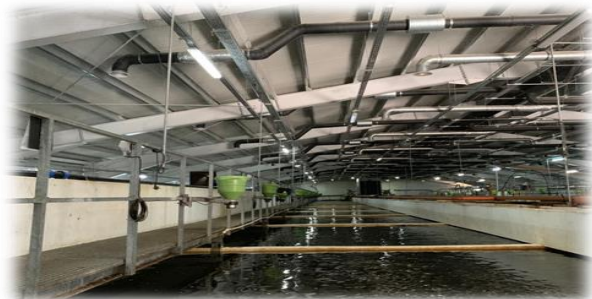
Figura 3.1- Sistem recirculant (RAS) în incinte acoperite
