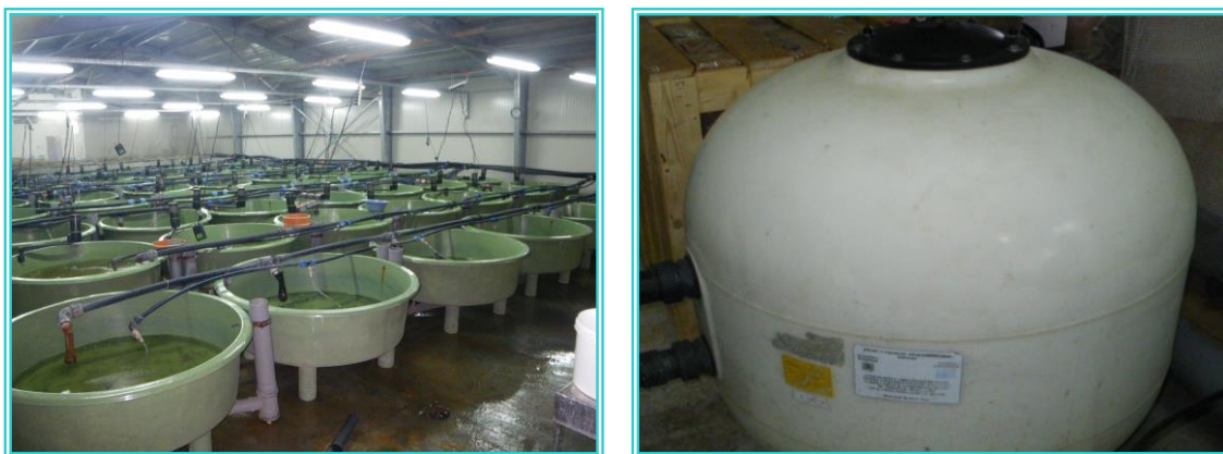
Foto 2.2 Detaliu hală- interior (stânga); Filtru cu particule de siliciu Crystal (dreapta)- (original)
