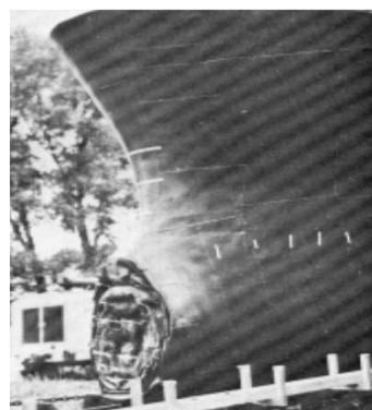
Fig.1.10. Distrugerea unei probe după un test de coliziune în Germania [6]
